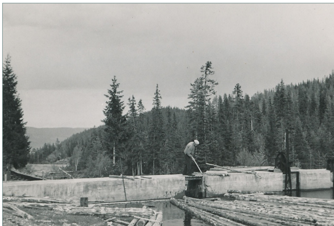
Svartvannsdammen ved Åvella. Åvella tømmerrenne synes i bakgrunnen av fotografiet. Mann i arbeid på demningen. Fotografiet er datert til mellom 1920 og 1930.
